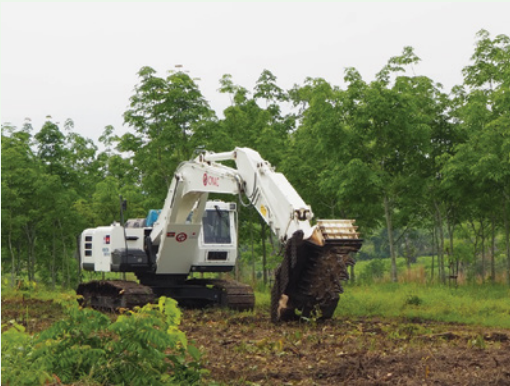
現場で作業にあたる灌木除去機
